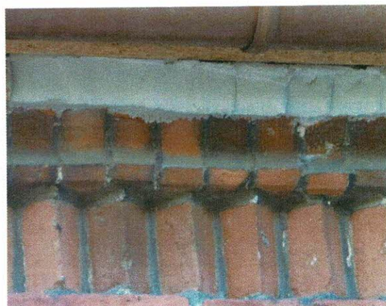
Liczne ubytki cegieł wypełnione cementem.
