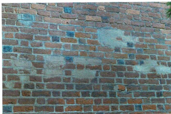
Liczne ubytki cegieł wypełnione cementem.
