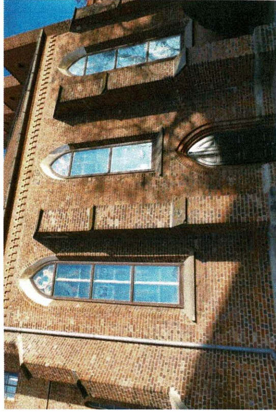
Ściana południowa nawy.
