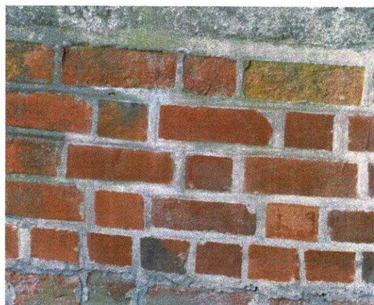
Uzupełnienia nową cegłą.
