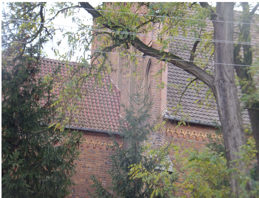
Foto 3 Aktualne poszycie dachu dachówka zakładkowa nad częścią główną oraz mnich mniszka nad prezbiterium
