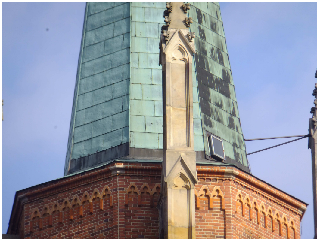
Foto 7 Destrukcja poszycia blachą miedzianą pokrycia helmu u jego nasady
