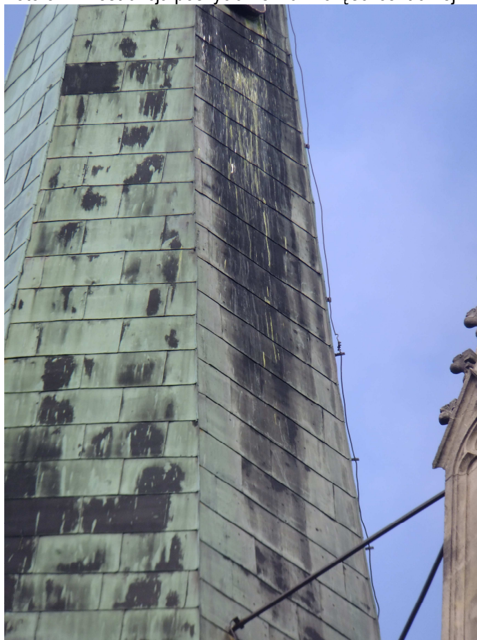
Foto 8 Destrukcja poszycia helmu w części centralnej
